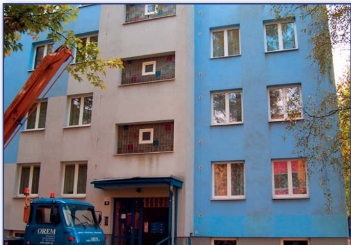
STAV PŘED ČIŠTĚNÍM
